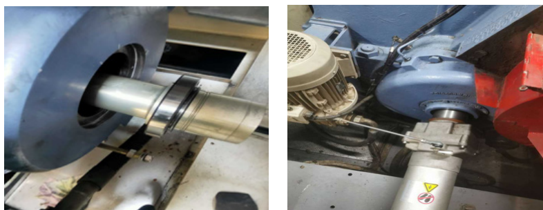
图4. 塔上维修更换
