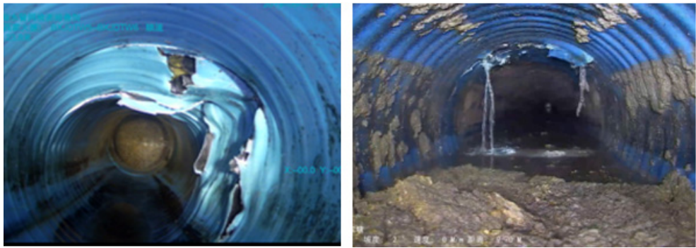
图5. 管道破裂
