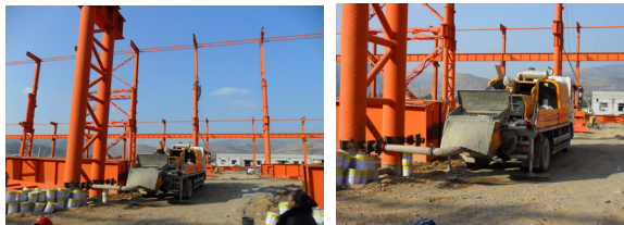
图3 混凝土泵送顶升施工过程
