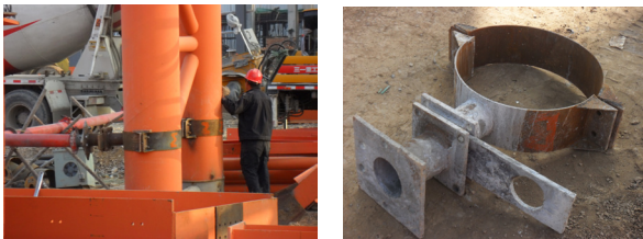
图2 短管与钢管柱及泵管连接方法
