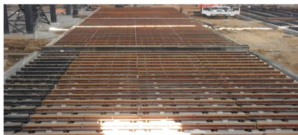
图1 T型槽铁的定位安装现场
