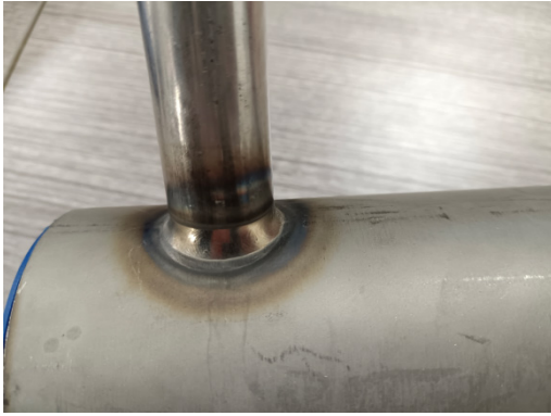
图6 集合管拔口焊缝外部成型良好
