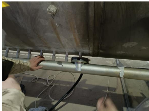
图11 使用管管密封焊机配套连接保护工装进行焊接
